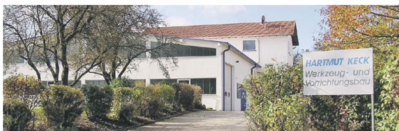
Das Betriebsgebäude im Gewerbegebiet Betzingen.
