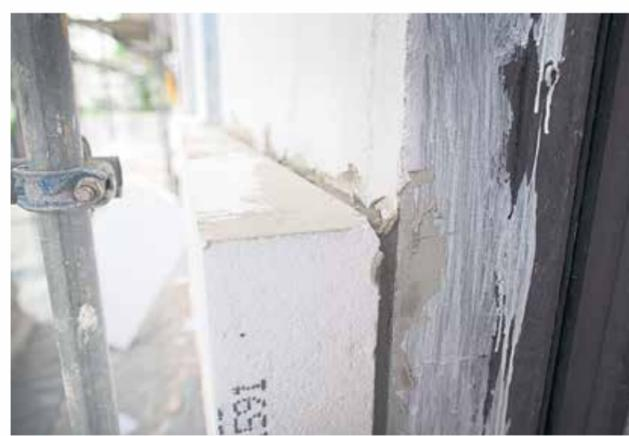
Weil das Flammschutzmittel HBCD mittlerweile verboten ist, wird die Entsorgung älterer Dämmschichten aus Styropor zum Problem. Foto: KfW-Bildarchiv
