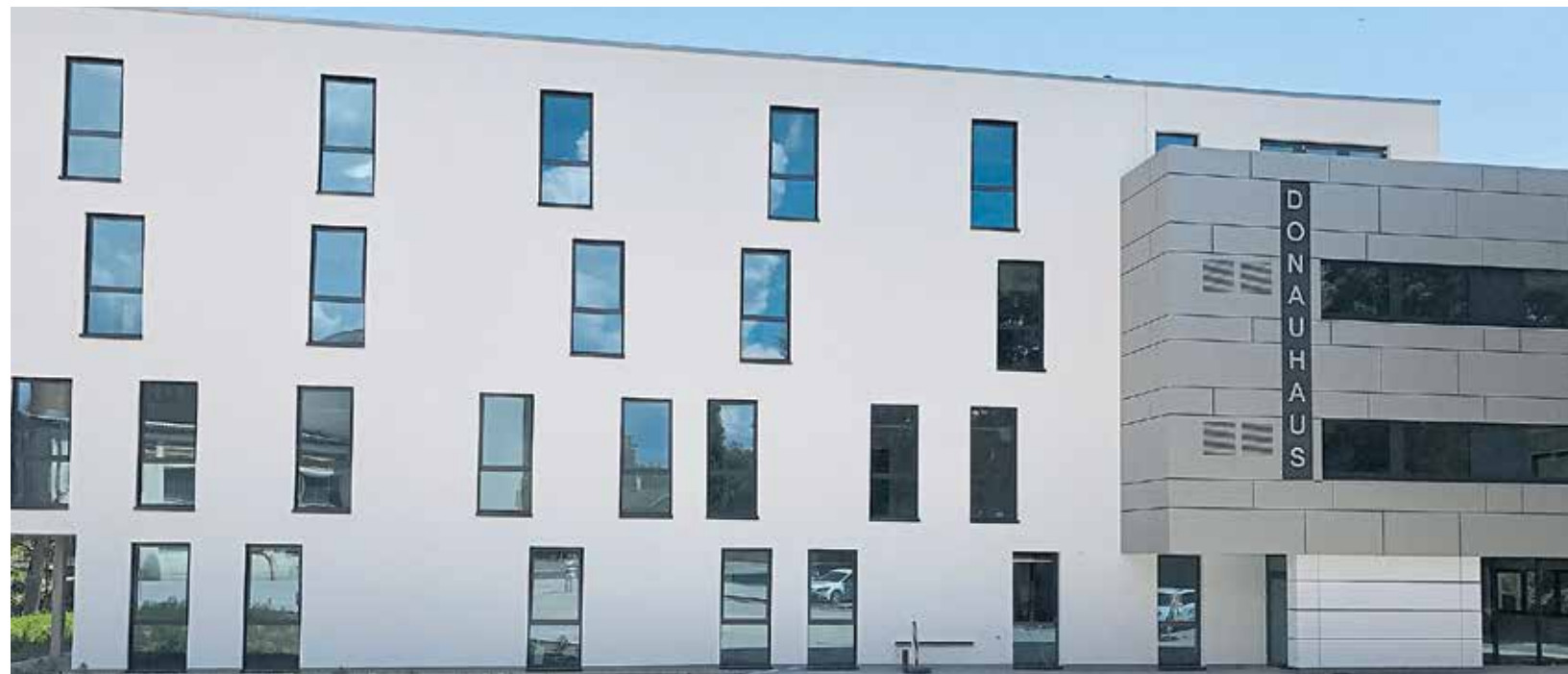
Bildungsakademie, Betriebsberatung und Starter-Center der Handwerkskammer Reutlingen sowie die Kreishandwerkerschaft Sigmaringen sind künftig hier zu finden: Die neue Anlaufstelle des Handwerks in der Hinteren Landesbahnstraße 7 in Sigmaringen. Foto: Bouß
