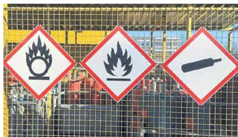
In der Regel sollen Gefahrstoffe nicht in Arbeitsräumen gelagert werden, sondern in einem separaten Bereich.
