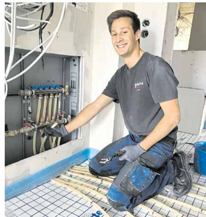
Damit es im Bad später nicht kalt wird: Jonas Klink schließt die Fußbodenheizung am Verteilerkasten an.
