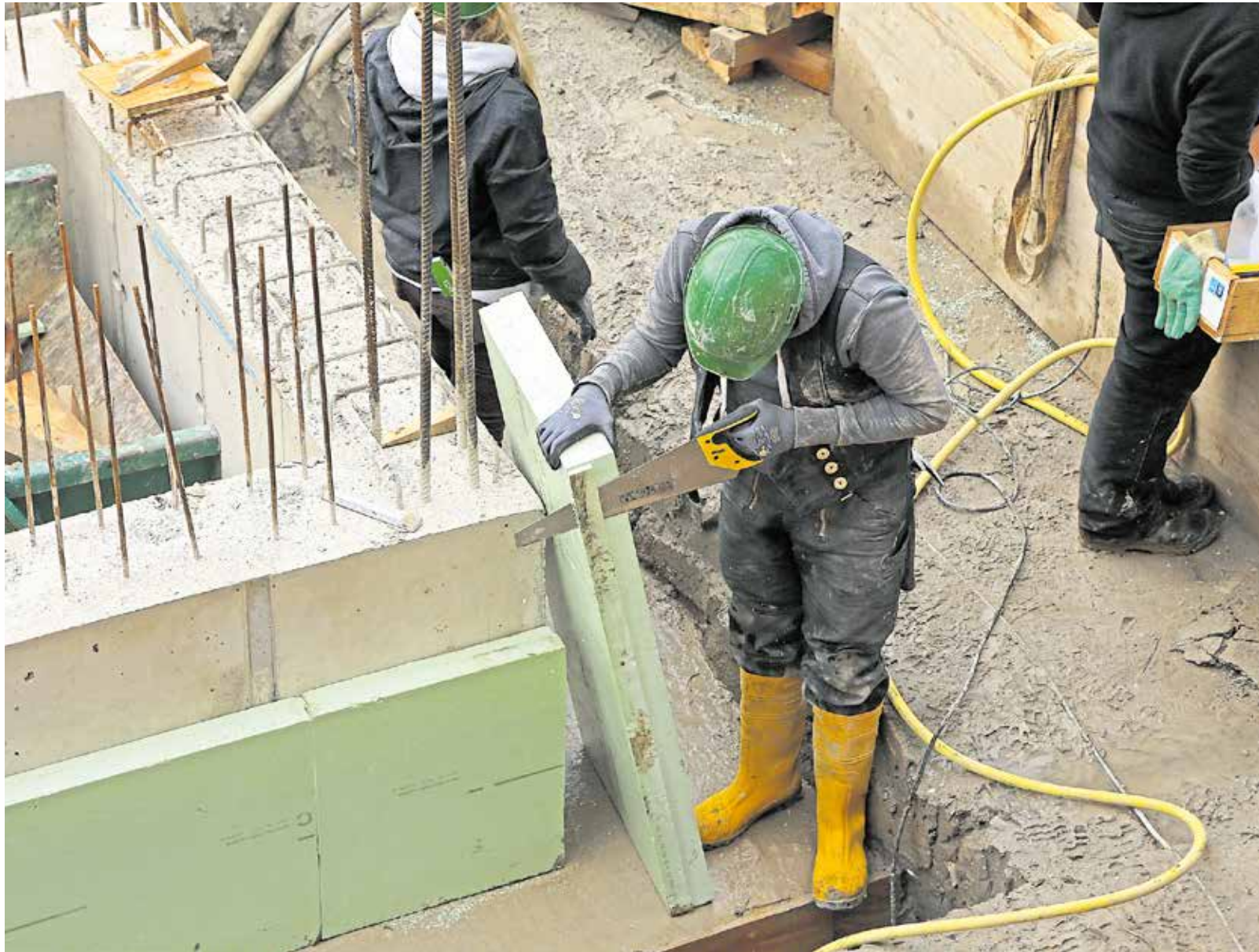
Auch bei Dämmmaterialien gibt es derzeit Lieferengpässe, was die Disposition und Termine auf Baustellen ins Wanken bringt.
