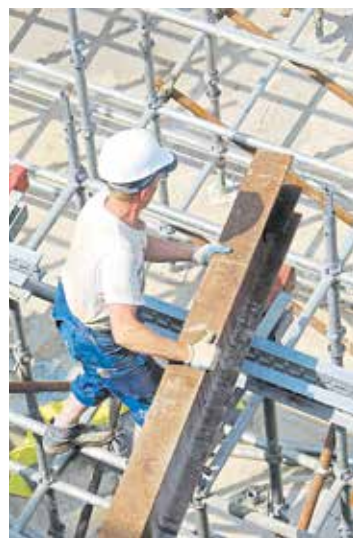
Die Auftragsbücher im Bauhauptgewerbe sind nach wie vor gut gefüllt. Hohe Preise, Materialknappheit und zuletzt auch steigende Zinsen drücken die Stimmung.
