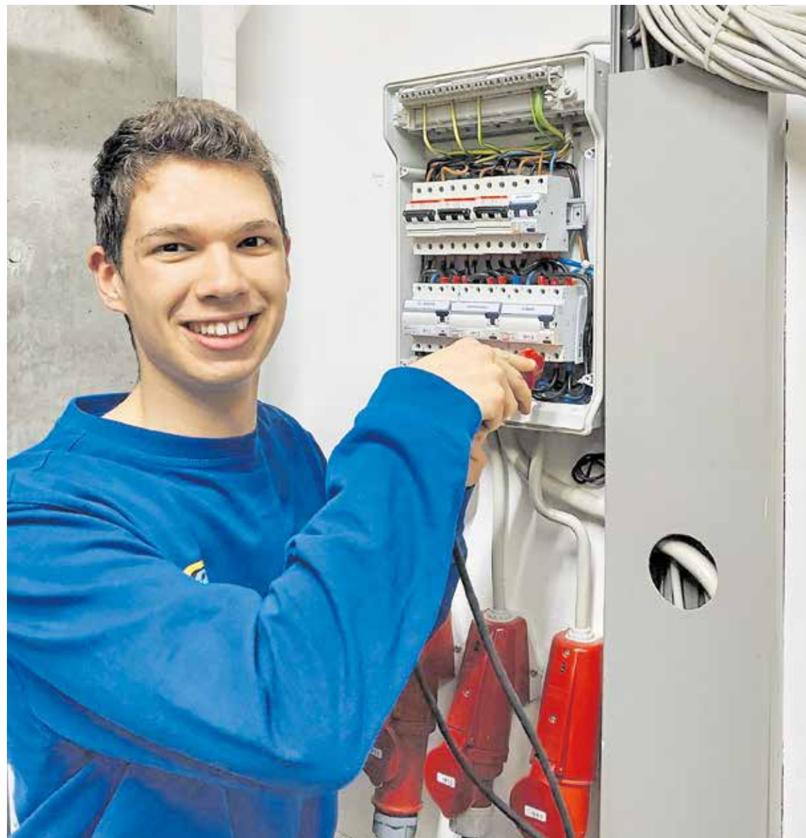
Nur keinen Schreibtischjob: Paul Hansen fühlt sich wohl auf der Baustelle.
