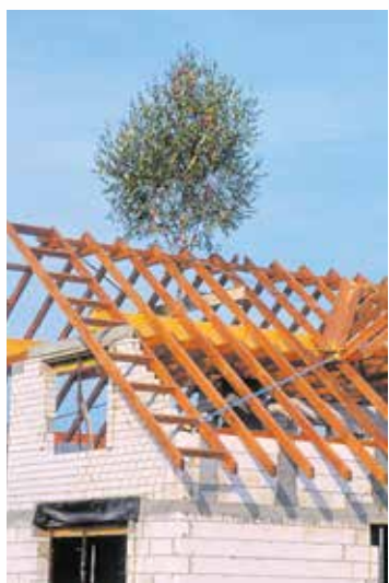
Richtfest im Eigenheim: Ein Traum, der sich für immer weniger Menschen erfüllt. Foto: Udo Kröner/Adobe Stock
