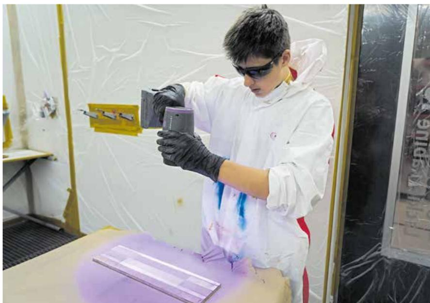
Mit einer UV-Lampe härtet ein Schüler eine lackierte Fläche. Foto: Handwerkskammer
