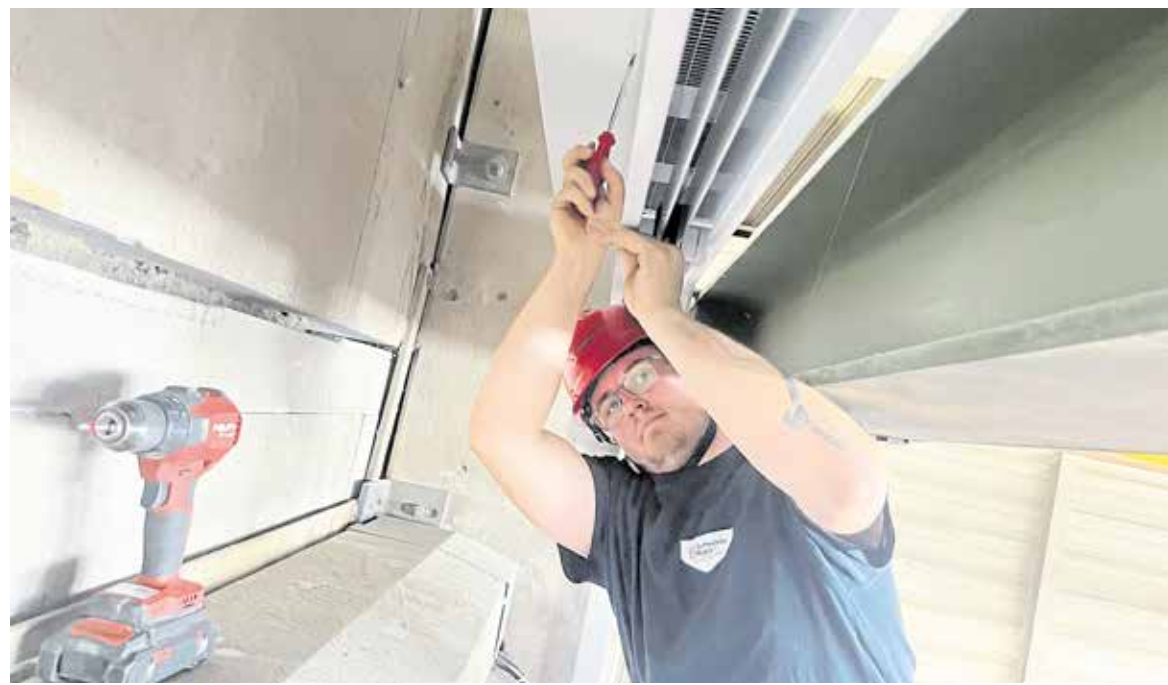
Moritz bei der Arbeit an einer Lüftungsanlage bei einem Rolltor in der Fertighausproduktionshalle bei Schwörer Haus. Foto: Schwörer Haus
