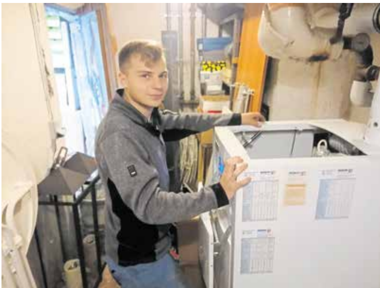
Bei der Installation im Bereich Sanitär und Heizung übernimmt Tobias Haug Reparaturen und Aufträge im Kundendienst und ist auch in der Blechbearbeitung tätig. Foto: Möhrle
