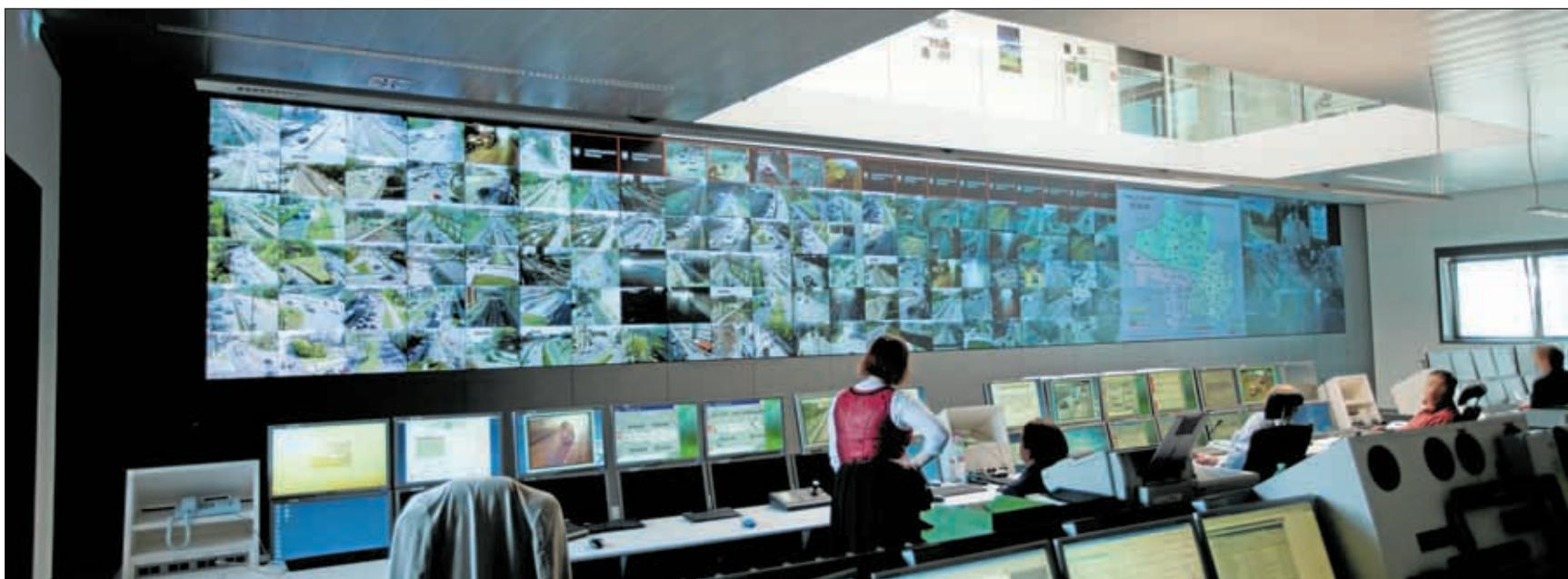
In der Münchner Verkehrszentrale werden mehrere hundert über die Stadt verteilte Kamera-Bilder und Schaubilder einer Steuerungssoftware auf einer von der Reutlinger Firma Eyevis gelieferten Monitorwand gezeigt, die aus 51 einzelnen Modulen besteht und 17 Meter lang ist. Bilder: Privat
