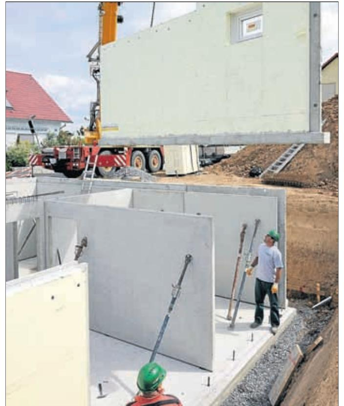
Betonfertigtellerteller bei der Montage einer KlimaPlus Wand mit integrierter Außendämmung.
